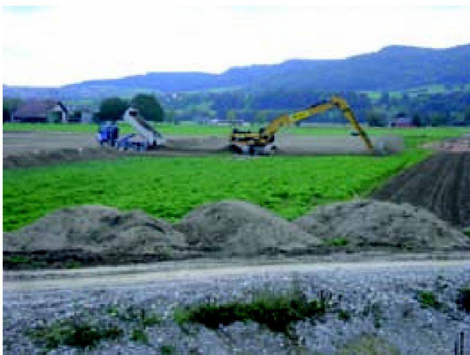
Abb. 3 und 4: Landwirtschaftliche Aufschüttung im Flaacherfeld (links): Das Material stammt aus den Thurauen, wurde nach strengen Vorgaben bezüglich Kornverteilung aufbereitet und sorgfältig auf die vorbereiteten Felder verteilt; die 30 cm dicke Schüttschicht wurde anschliessend mittels Rotationsspatung mit dem Untergrund vermischt; die Folgebewirtschaftung dauert je nach Bodenentwicklung 3–4 Jahre. Neuer Hochwasserschutzdamm im Bau (rechts): Das Material stammt aus den Aufweitungen der Thur.
