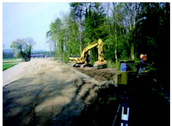
Abb. 3 und 4: Landwirtschaftliche Aufschüttung im Flaacherfeld (links): Das Material stammt aus den Thurauen, wurde nach strengen Vorgaben bezüglich Kornverteilung aufbereitet und sorgfältig auf die vorbereiteten Felder verteilt; die 30 cm dicke Schüttschicht wurde anschliessend mittels Rotationsspatung mit dem Untergrund vermischt; die Folgebewirtschaftung dauert je nach Bodenentwicklung 3–4 Jahre. Neuer Hochwasserschutzdamm im Bau (rechts): Das Material stammt aus den Aufweitungen der Thur.
