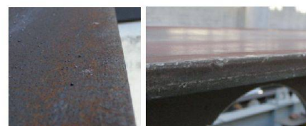
Fig. 3: Aperçu des défauts «physiques» pouvant altérer les mesures des arêtes.
