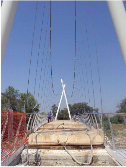
Abb. 6: Als Gewichte kamen mit Wasser gefüllte Behälter zum Einsatz.
