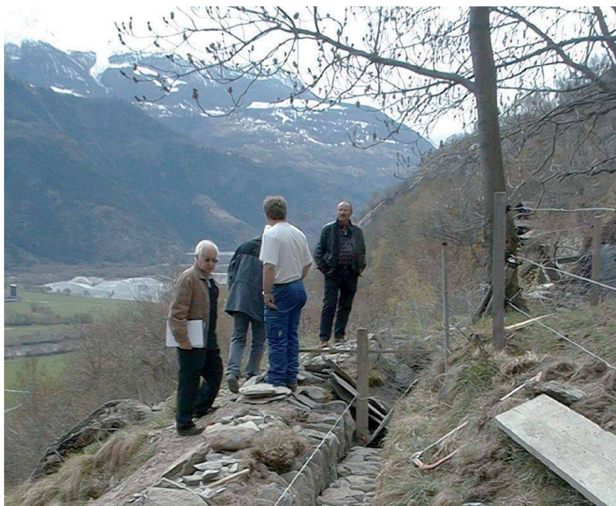
Abb. 5: Baltschieder-Wyngartneri-Tretschbord im Bau.
