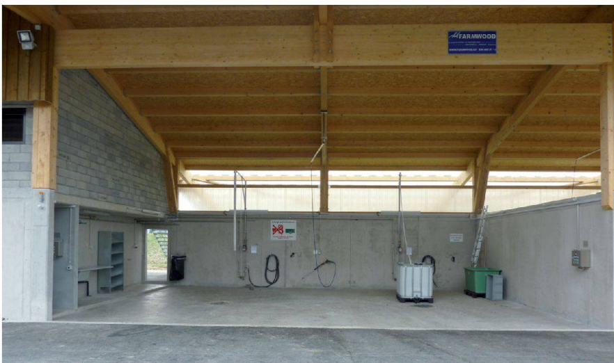
Fig. 4: Place de lavage.
