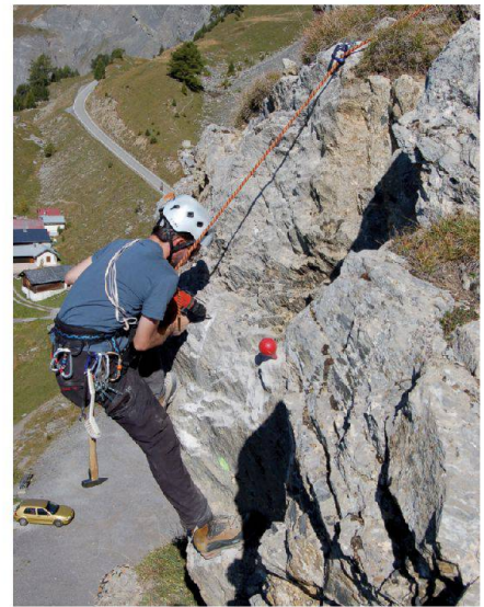
Abb. 1: Vermarkung einer Rückversicherung im rohen Fels.
