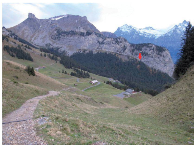
Abb. 7: Blick ab Wanderweg zur Schynige Platte Richtung Schiltwald mit Tunnelportal West (roter Pfeil). Im Vordergrund die fertig gestellte Nebenerschliessung zum «Ausser- und Innerläger» (Herbst 2013).
