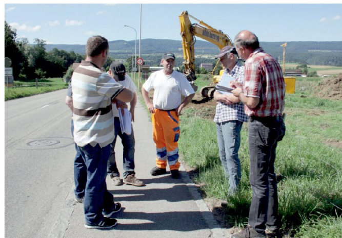
Abb. 3: Die Kommunikation ist auch innerhalb der Baustelle wichtig (GM Wahlen).
