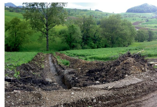
Abb. 2: Bau Drainage, A- und B-Horizont (Neueten, Niederdorf BL).
