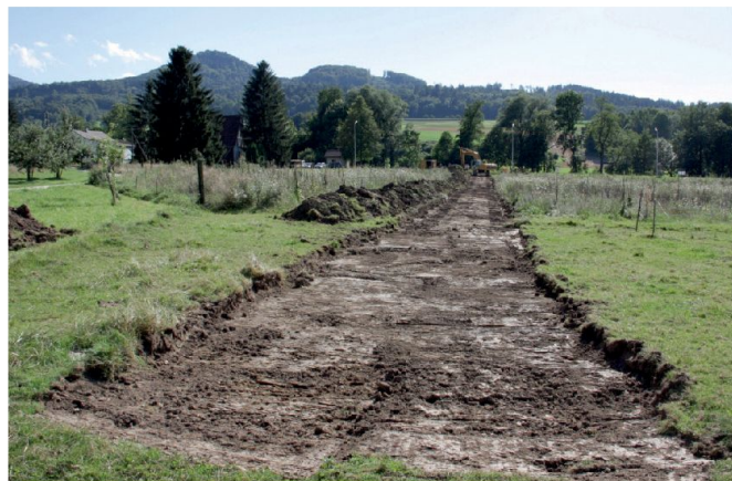
Abb. 4: Erdarbeiten im Rahmen eines Wegebaus bei sehr trockenen Verhältnissen und leistungsfähigen Maschinen (GM Wahlen).
