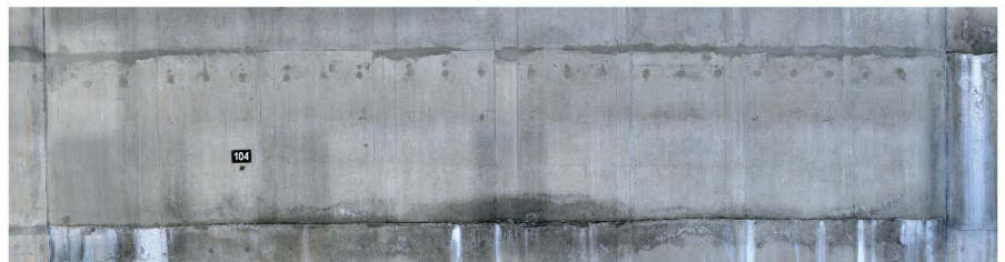
Fig. 8: Résultat d'une ortho-photo, composée d'une trentaine d'images.
