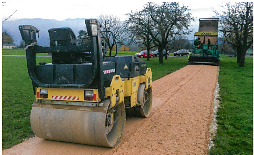
Abb. 3: Neubau eines Weges in der Gesamtmelioration Blauen.
