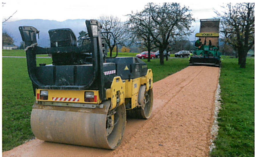
Abb. 3: Neubau eines Weges in der Gesamtmelioration Blauen.
