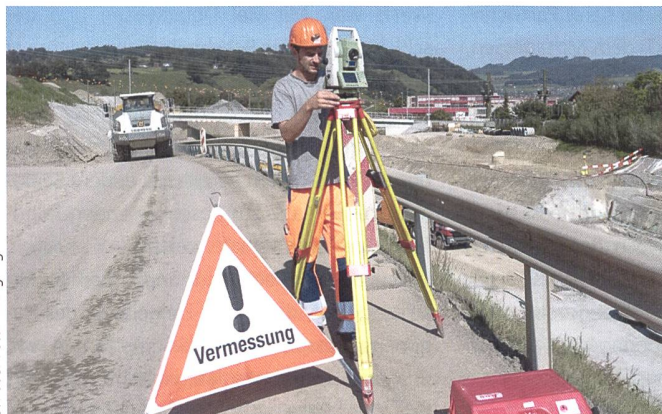
Urheber Foto: Ristag Ingenieure AG.
