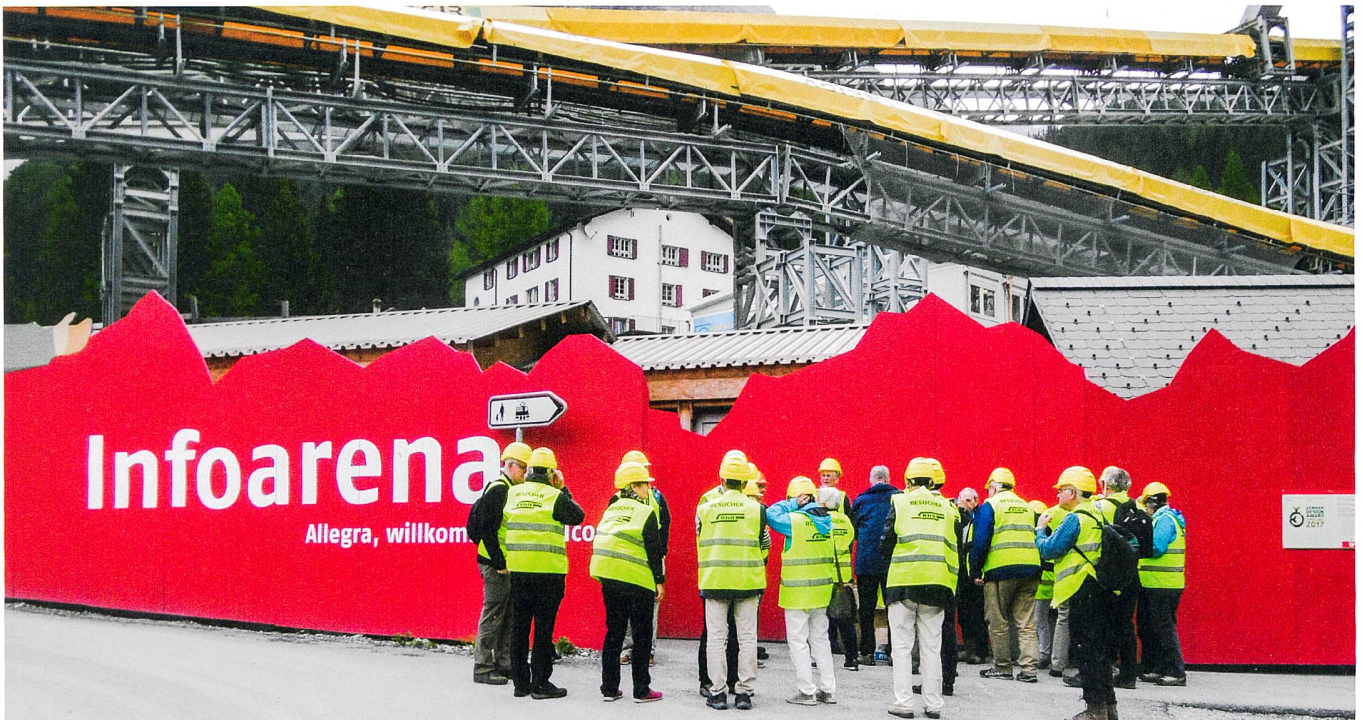
Abb. 4: Preda: Start zur Baustellenbesichtigung.
