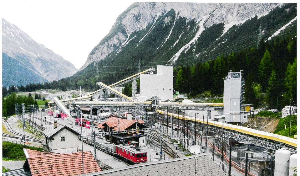
Abb. 3: Preda: Überblick auf die Baustelle.
