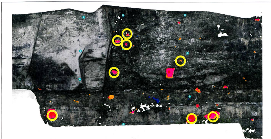
Fig. 6: Inspection E1 – E2 (cercles jaunes = décrochements).
