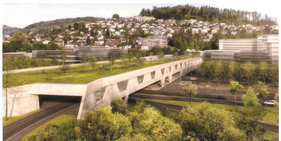
Abb. 7: Überdeckung des Tunnelportals des neuen Autobahnbypasses.
