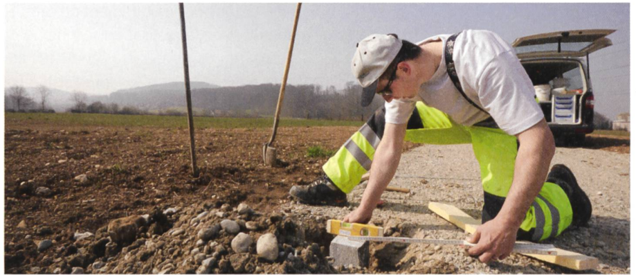
Fig. 4: Specialista di terminazione al lavoro.
