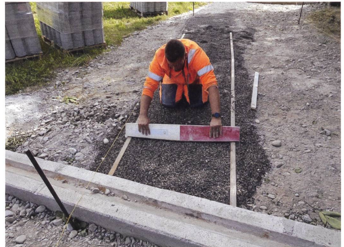
Abb. 9: Vorbereitung der Versetzung der Rasengittersteine (man beachte das negative Dachprofil der Planie der Spur zur Ausbildung einer wasserführenden Rinne mittig der Steine).
