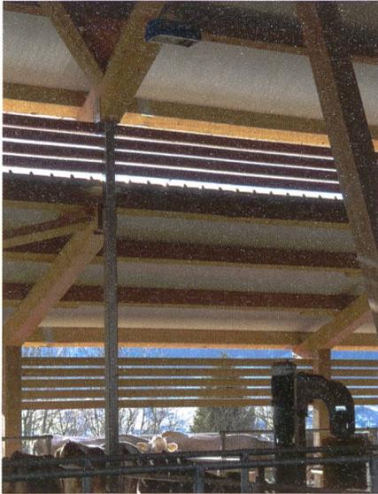
Abb. 6: Die Leuchten sind so angebracht, dass von aussen nur indirektes Licht zu sehen ist.
