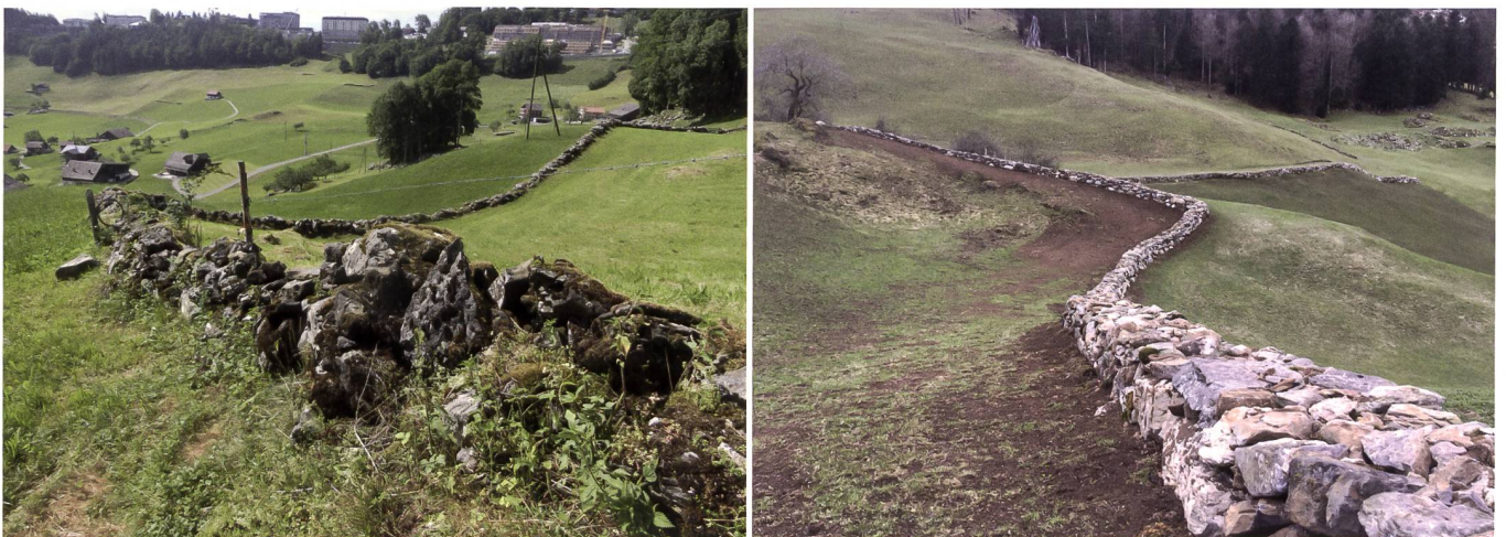
Abb. 4 und 5: Die zweihäuptige Mauer Geissmattli (Seite Obbürgen), welche teilweise nur aus einer Steinbreite bestand, war auf ihrer ganzen Länge instabil. Stellenweise konnte durch die Mauer geblickt werden. Nach der Sanierung: Mit den zahlreichen umliegenden Steinen wurde die Mauer mit einer Breite von ca. 0.8 m neu aufgebaut. Sie stellt ein sehr markantes Element in der Landschaft dar. Zweihäuptige Trockenmauern sind auf dem Gemeindegebiet von Ennetbürgen nicht häufig anzutreffen.
