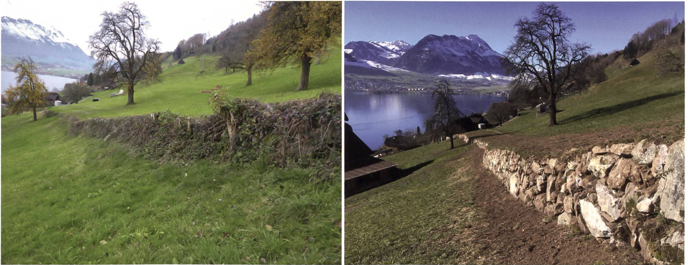
Abb. 2 und 3: Vor der Sanierung war die Mauer Geissmattli (Südhang) kaum noch zu erkennen. Humusablagerungen am Mauerfuss, Efeu und Brombeeren verdeckten die Trockenmauer. Das Mauergefüge war bis auf wenige Abschnitte instabil. Nach der Sanierung: Mit den vorhandenen Steinen konnte die Mauer auf ihrer ganzen Länge saniert werden. Die Humusablagerungen unterhalb der Mauer konnten in die Mulden, die durch das Auswaschen hinter der Mauer entstanden, eingebaut werden. Dies erleichtert die Bewirtschaftung der Wiesen sowohl ober- als auch unterhalb der Mauer.
