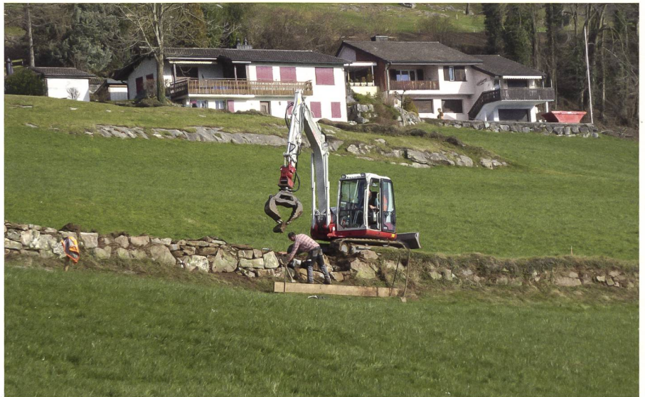
Abb. 6: Sanierung der oberen Grenzmauer im Gebiet Tuschmatt. Hier arbeitet der Grundeigentümer mit. Holztafeln schützen das unterliegende Gelände von wegrollenden Steinen.
