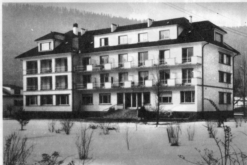
Le Home de Fleurier, une grande maison claire. Toutes les chambres sont individuelles ; leur confort est très étudié.
