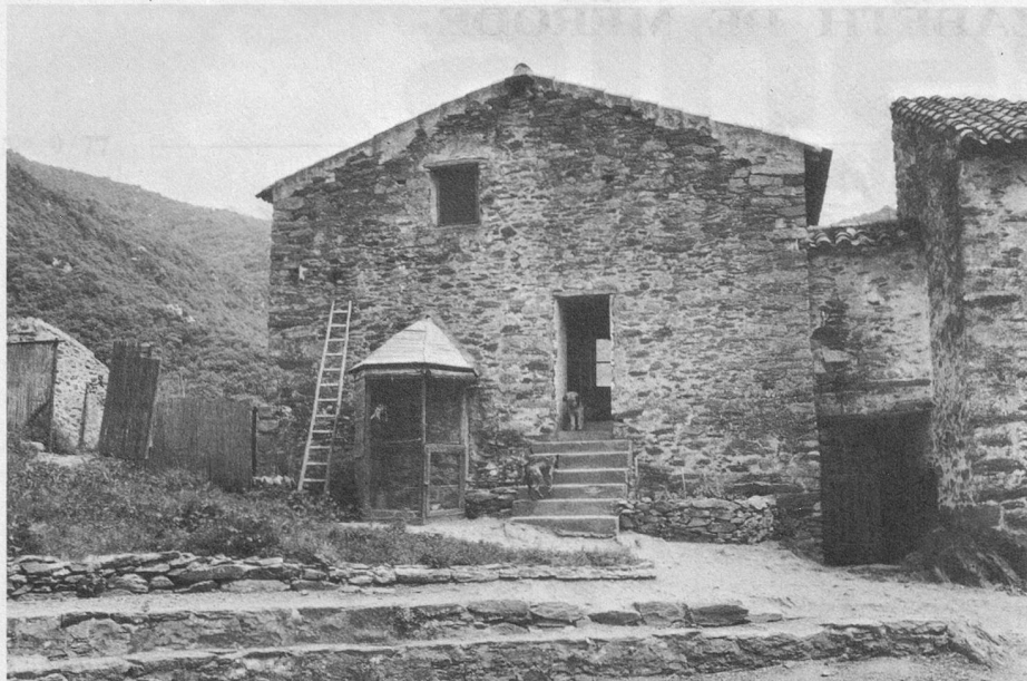
Grâce à ses nouveaux propriétaires, l'antique village de Montalba revit. Les de Mérode consolident les murs en respectant les vieilles pierres et aménagent les locaux.
