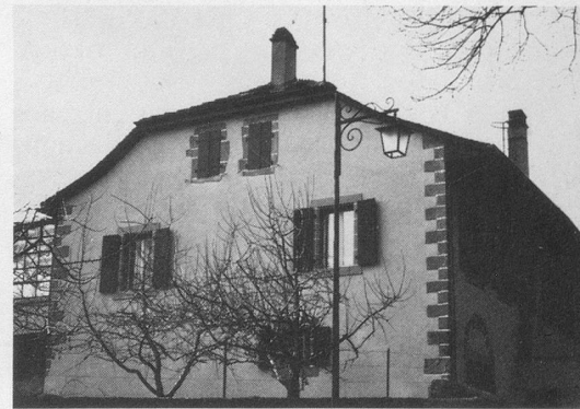
L'ancien bâtiment d'école d'Echandens.
