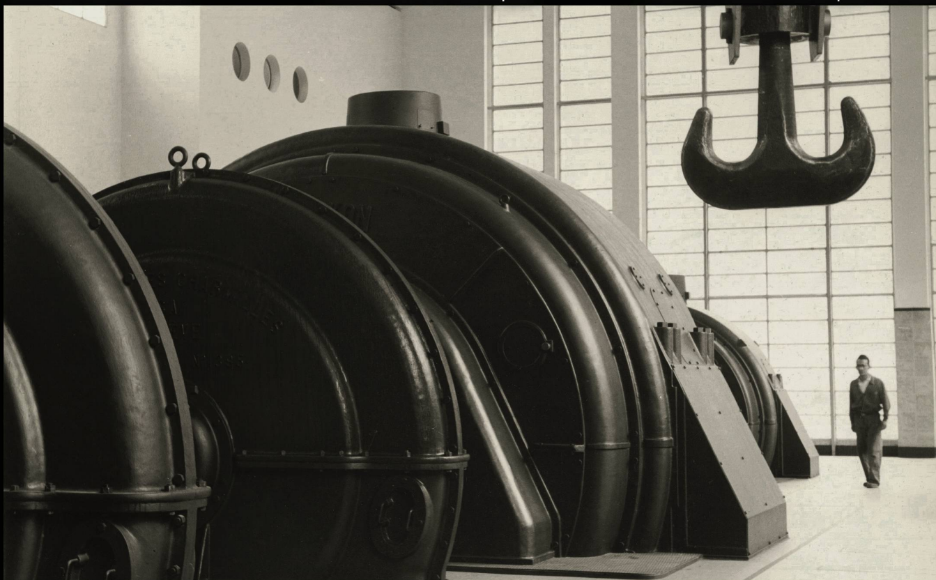
Usine électrique, la Grande-Dixence.
