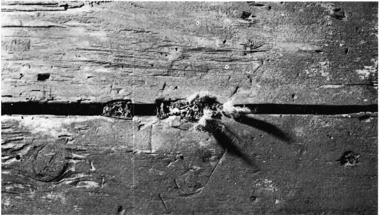
Abb. 10 Kriens-Zumbhof Hanfverpflöckung im Schwundriß eines Blockwerkbalkens im Wohngeschoß
