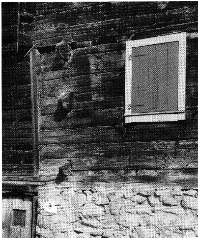
Abb. 3: Fassadenbündige Bodenbohlen und unregelmässige Einzelvor- stösse (Morschach, Tannen, 1317/ 41).
