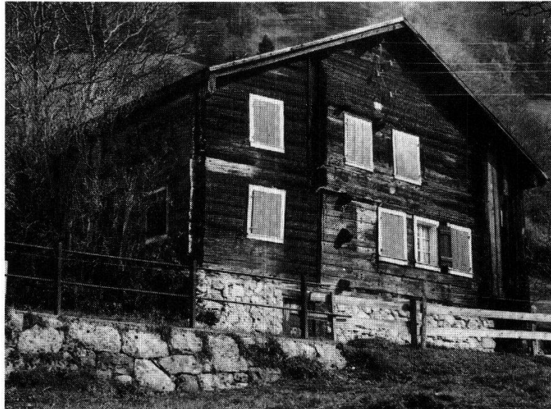
Abb. 14: Morschach, Tannen, 1317/41: Ansicht von Nordwesten.
