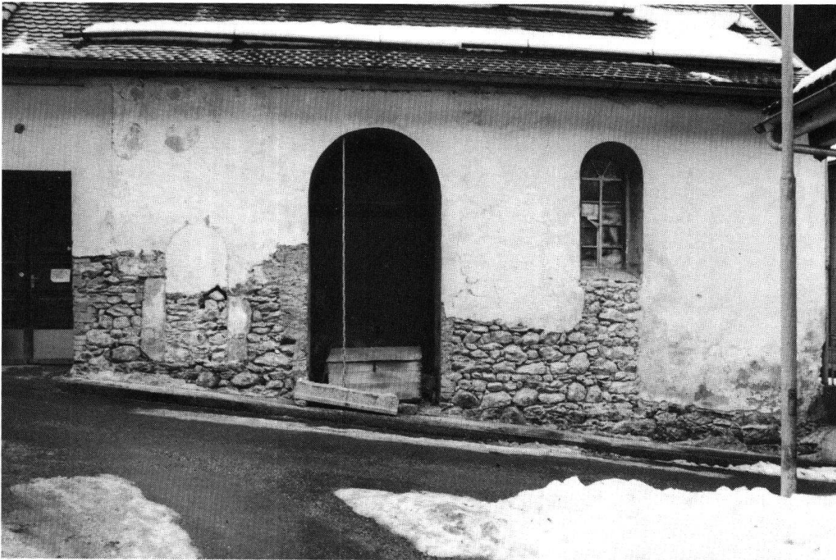
Abb. 9: Alte Kirche Göschenen: Schiff-Nordfassade mit ursprünglichem, heute vermauertem Seiteneingang.
