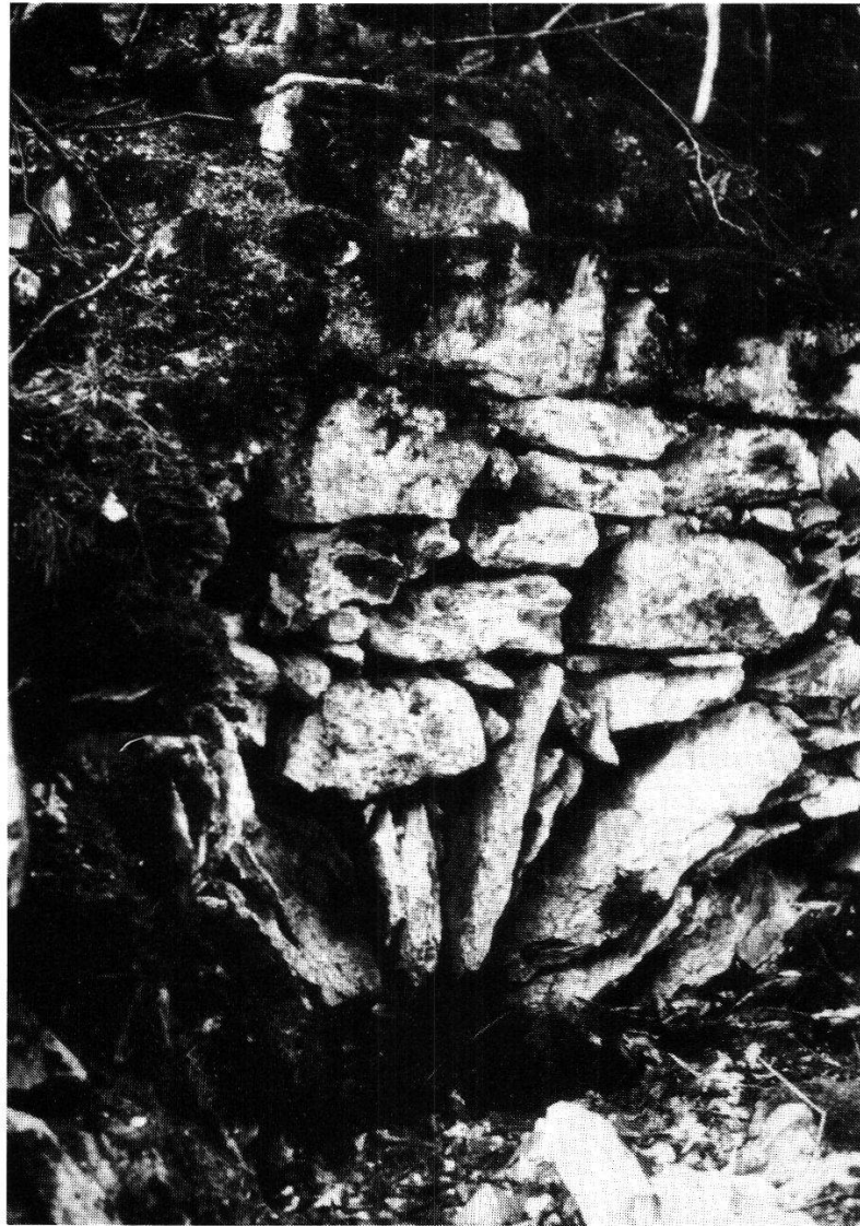
Abb. 7: Kalkofen Frentschenberg, Am- steg: Sturzbogen über der Schnauze.
