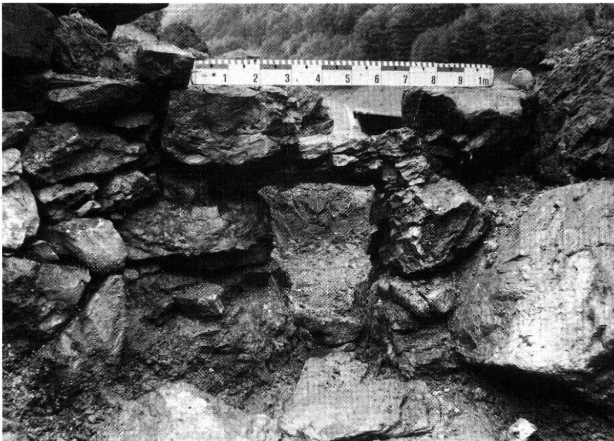
Abb. 6: Kalkofen im Biel, Isenthal: Ansicht der Schnauze von innen.
