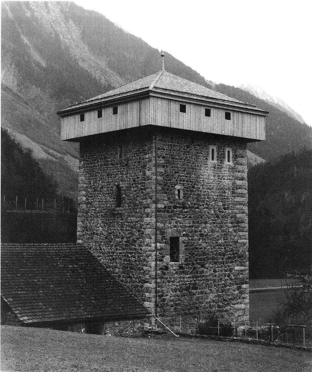
Abb. 11: Meierturm von Silenen. Der Turm mit aufgesetztem Dach und Laubenumgang, von Osten. Auf der Nordseite ist der Hocheingang und auf der Ostseite der Austritt zum Aborterker zu erkennen.
