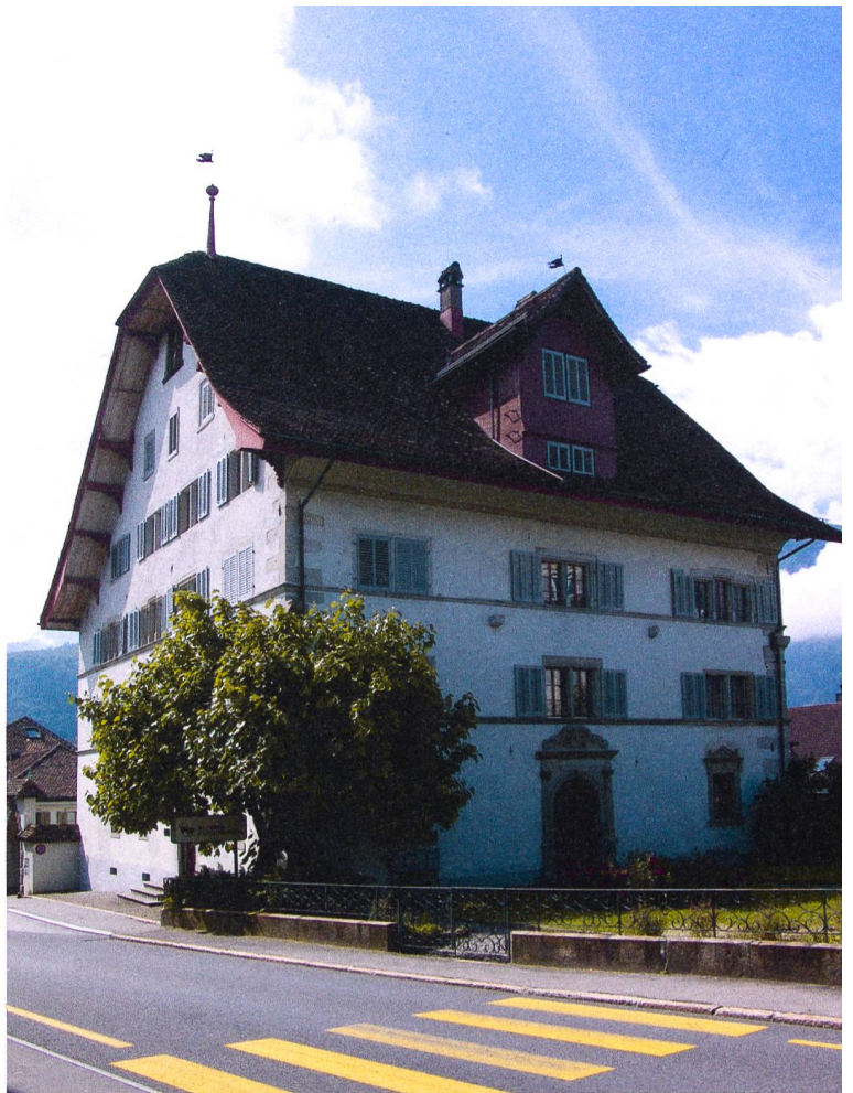
Abb. 18: Das Grosshus, erbaut durch Heinrich Reding im Jahr 1604, orientiert sich an Bürgerhäusern der Spätrenaissance süddeutscher Städte.
