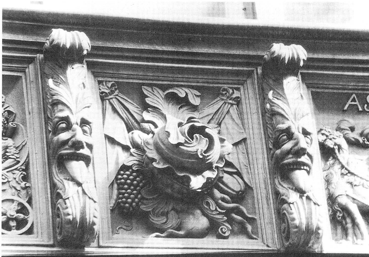
Abb. 24 Am Erker eines Altstadthauses an der Schmiedgasse 15 in St. Gallen.
