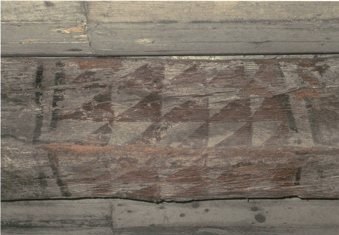
Die fortlaufenden Ornamentstreifen der Balkenmalereien an der Martinsgasse 13 verlaufen nicht längsgerichtet, sondern umwickeln die drei sichtbaren Balkenseiten im Querverlauf.
