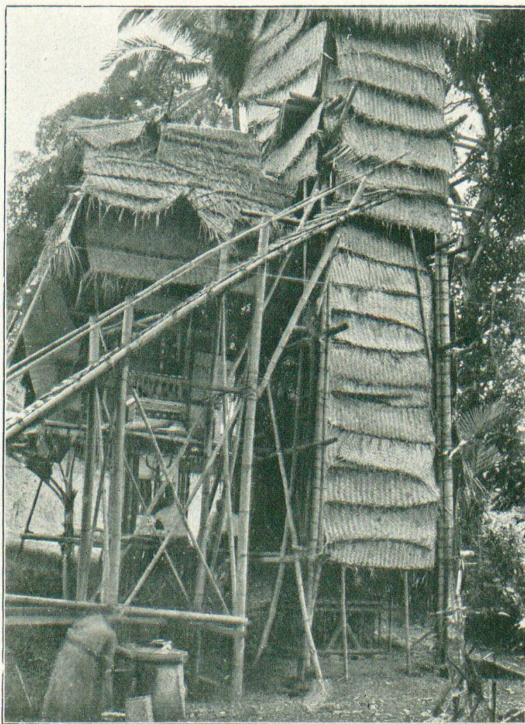
Abb. 1. Ein im Bau befindlicher Verbrennungsturm (wadah).
