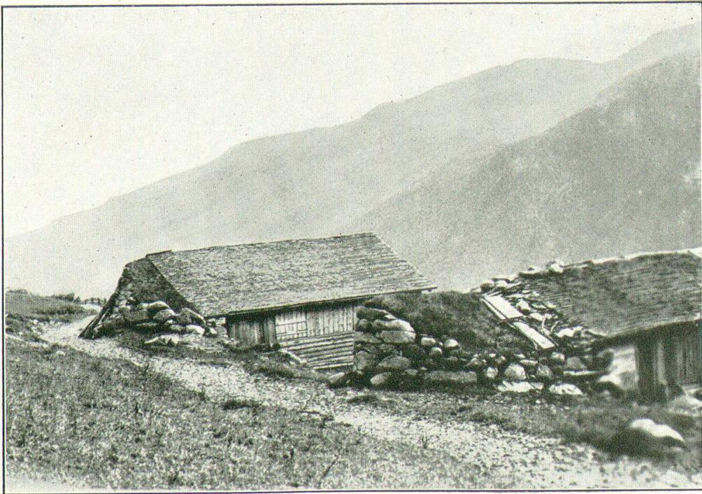
Abb. 11. Keilmauer als Lawinenschutz bei Scharinas.
