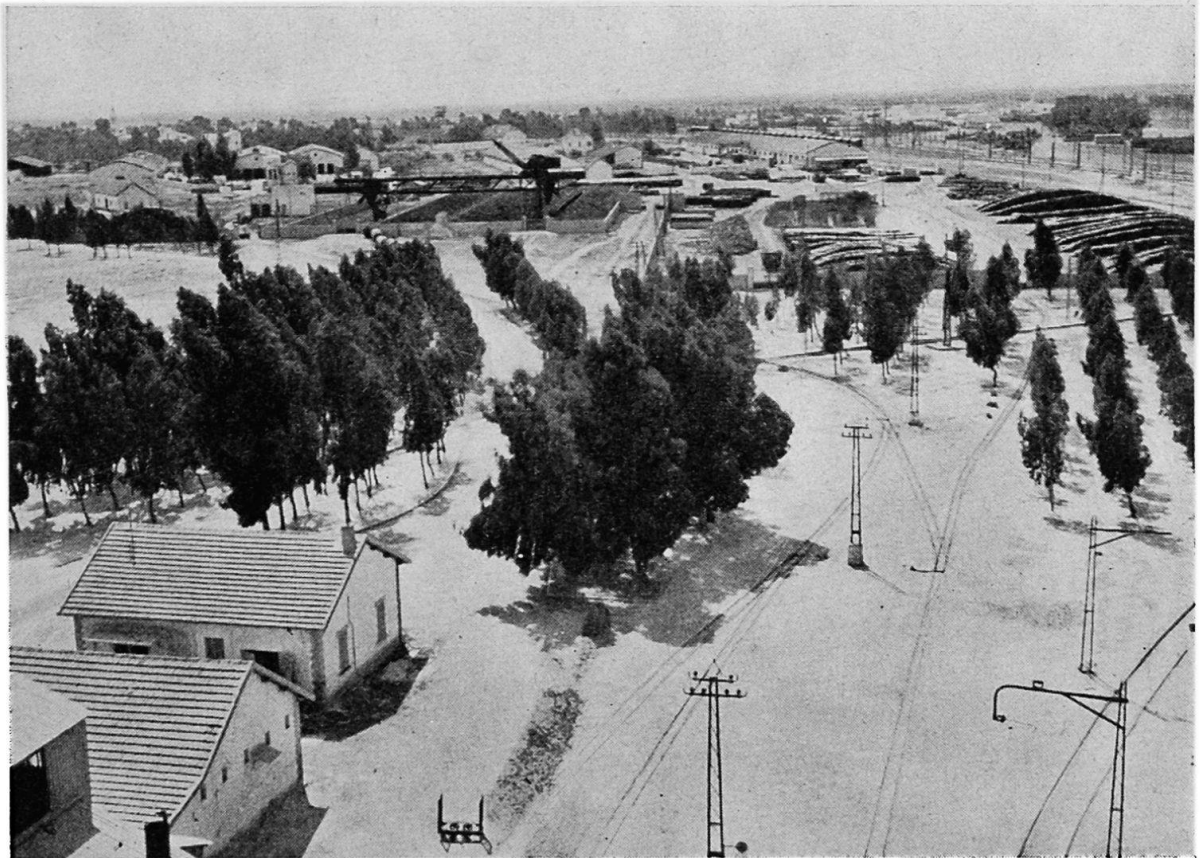
Fig. 4. Khouribga: im Vordergrund ein Teil der Phosphatwerke, im Hintergrund die Europäersiedlung
