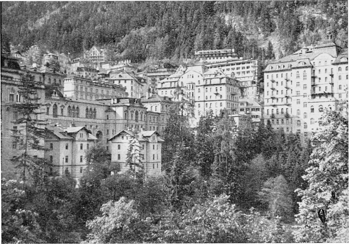
Hotelstadt Bad Gastein. Blick gegen die westliche Talflanke am Stubnerkogel (2248 m) Photo J. HöSL, 12. 10. 51
