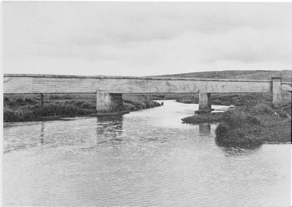
Abb. 3: Die Heißwasserleitung quert als moderner Aquaedukt einen Fluß. Täglich fließen rund 30 000 m 3 Heißwasser durch den Leitungsquerschnitt.
