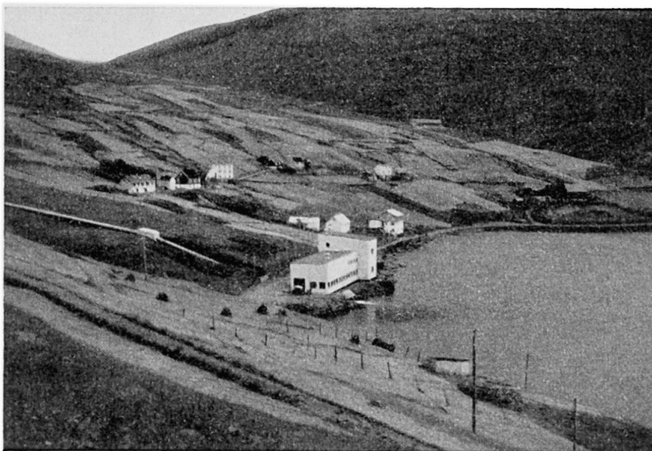
Abb. 5: Modernes Elektrizitätswerk bei Vestmanna am Vestmannaafjord (Streymoy). Im Vorder- und Hintergrund die den Ort umgebende Indmarksfläche.
