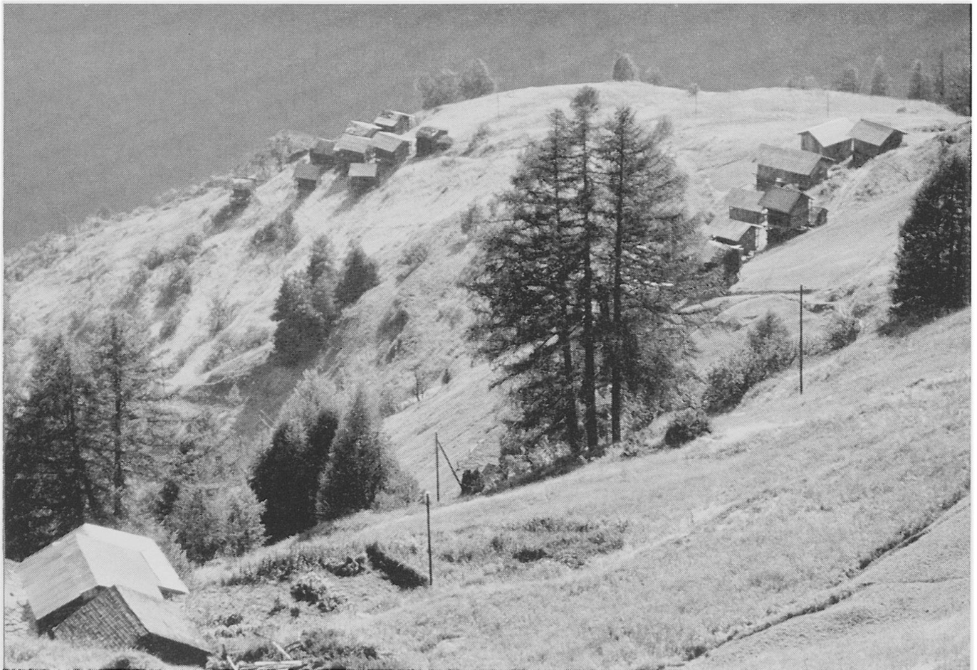
Abbildung 6. Maiensäß Le Joc und La Rèche : Im linken Bildteil erscheinen noch die äußersten Gebäude von Le Joc; rechts und oben im Foto sind Häusergruppen von La Rèche zu erkennen. Viele Gebäude befinden sich in sehr schlechtem Zustand, einige sind bereits zerfallen. Intakte Bissen und gemähte Wiesen sehen wir nur vorn rechts und zwischen dem Waldrand und den Gebäuden von La Rèche (rechts im Bild)
