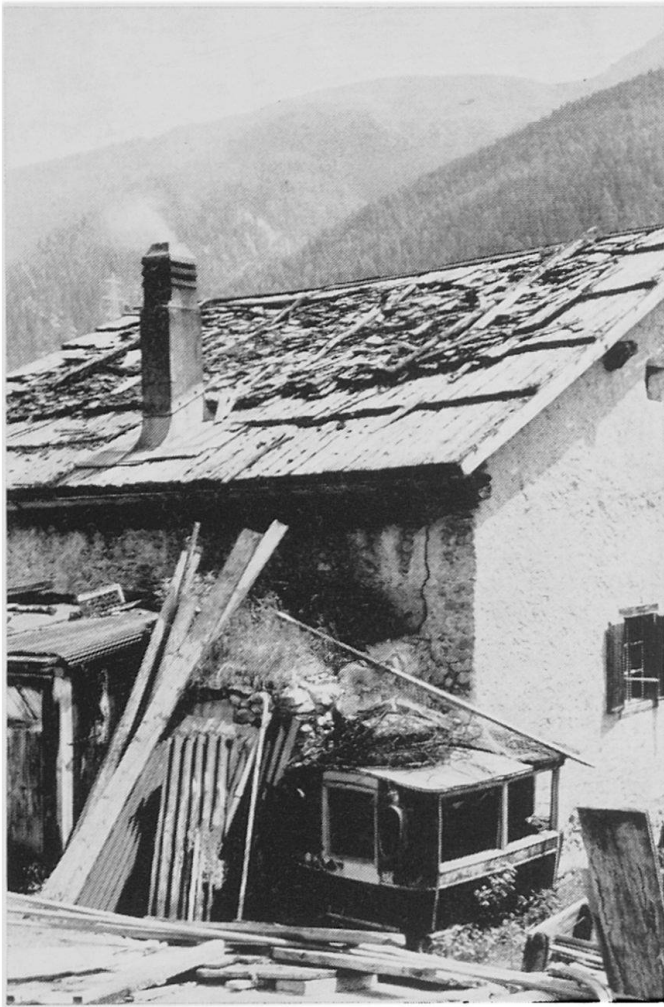
Abbildung 8. Kaum sichtbar ist der einzige noch erhaltene, aus der Wand herausragende Backofen (Haus Familie Waser)
