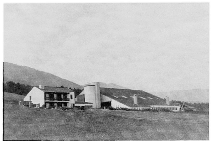
Photo 6. Ferme de «colonisation» à Bevaix. Maison dissociée: maison d'habitation, silo, «rural» à tripartition longitudinale en gradins (aire d'engrangement, grange, étable)
