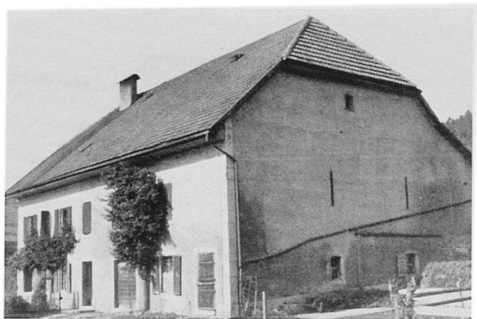
Photo 4. Ferme maltournée de Chézard-St-Martin à tripartition transversale (au rez-de-chaussée: logement, fourragère, étable; au premier étage: logement et grange)
