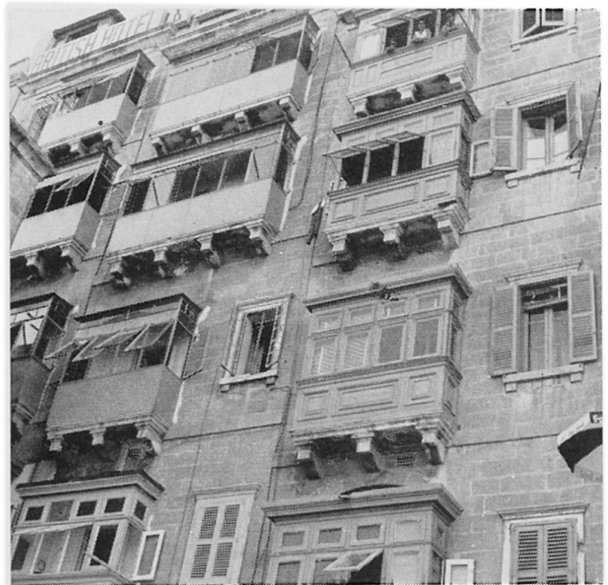
Abbildung 2. Balkonetagen im maurisch anmutenden Stil im Hafenviertel von Valletta
