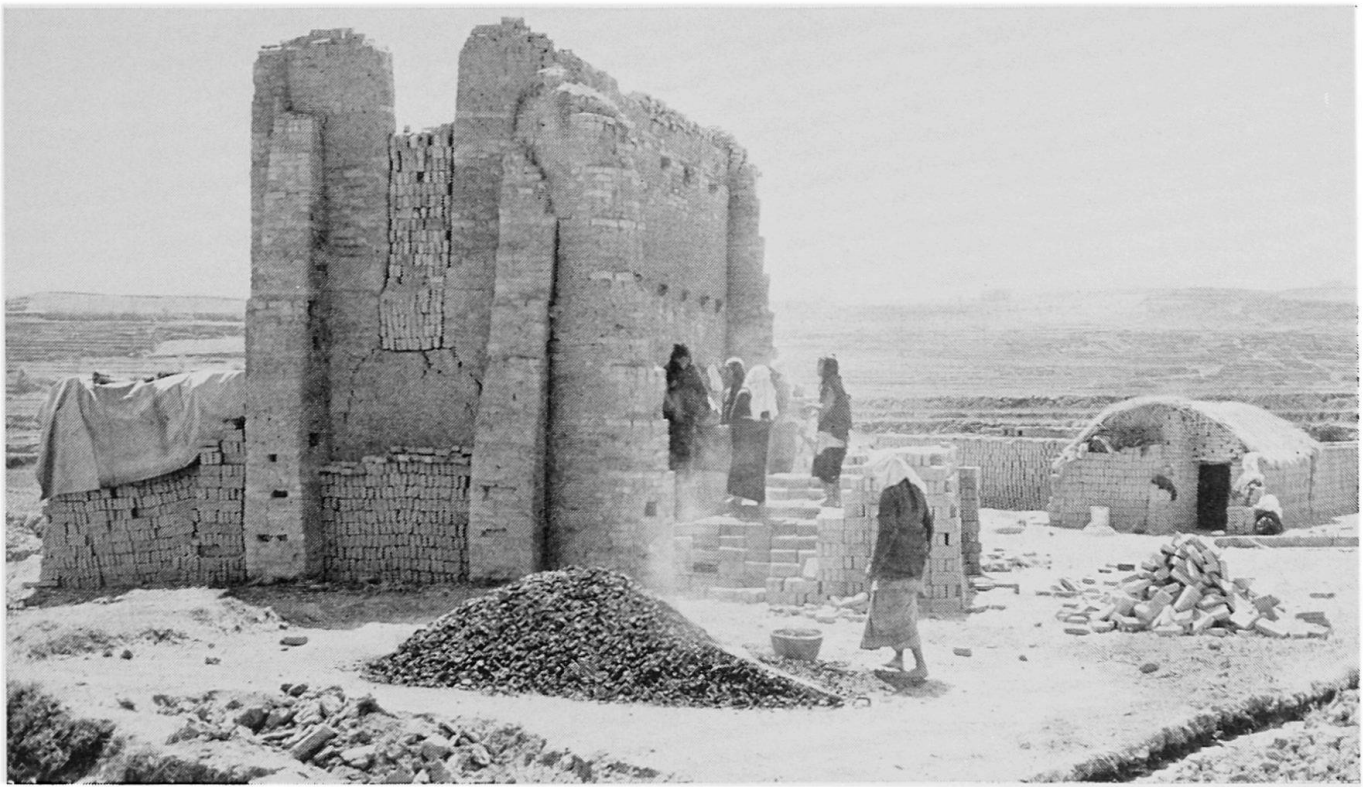
Abbildung 6. Ziegelofen. Standort (wie Abb. 5) linkes Ufer des Naku Khola südlich von Jawlakhel. – Aufnahme HB März 1968
