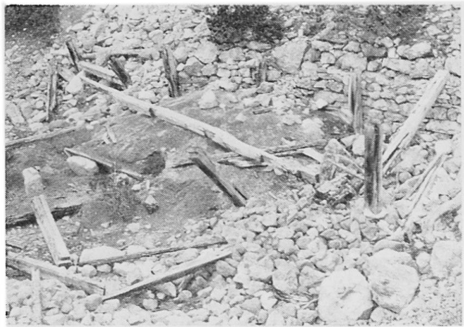
Abbildung 3. Übertaganlagen in Obermadlein, 2150 m
