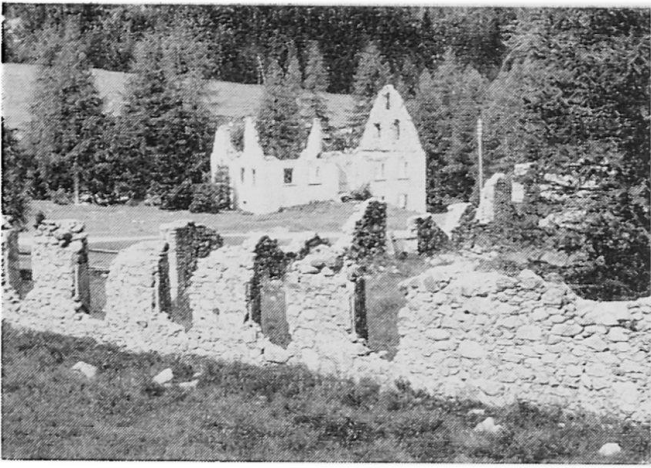
Abbildung 4. Ruinenkomplex «Schmelzra». Im Vordergrund ein Teil von Gebäude A, Raum 1, im Hintergrund Gebäude C
