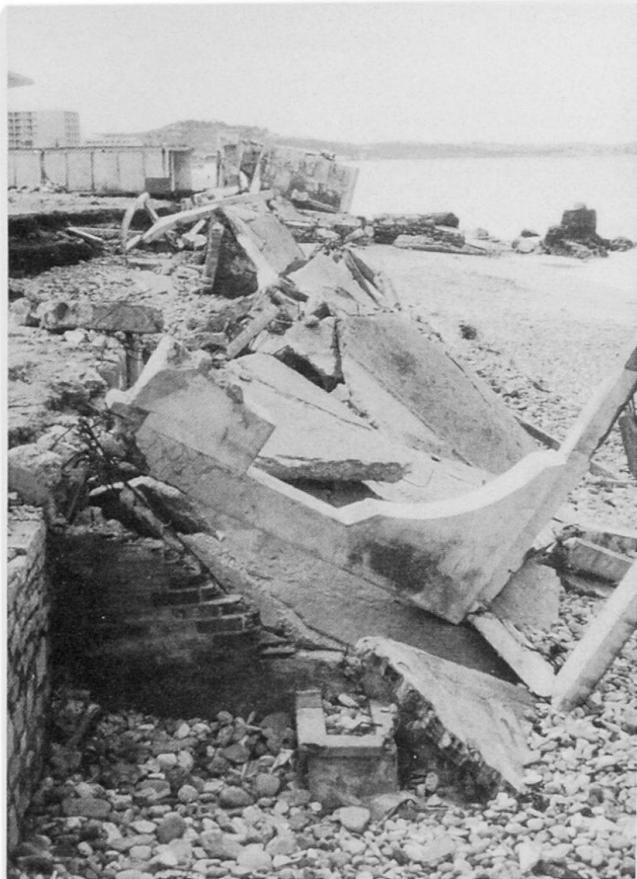
Foto 6: Zerstörte Teile neuer Hotelanlagen im Ostteil der Bucht von Tanger.
