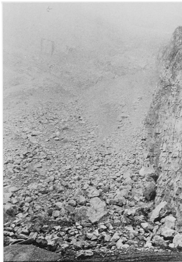
Abb.4 Bergsturzmasse im Steinbruch, photographiert Anfang Februar 1974. Etwa 55\,000\text{ m}^3 Material sind hier liegengelieben.
