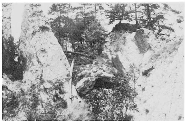
Figure 2 Vue générale des lieux. Blocs éboulés, basculés et falaises en pleine évolution.
