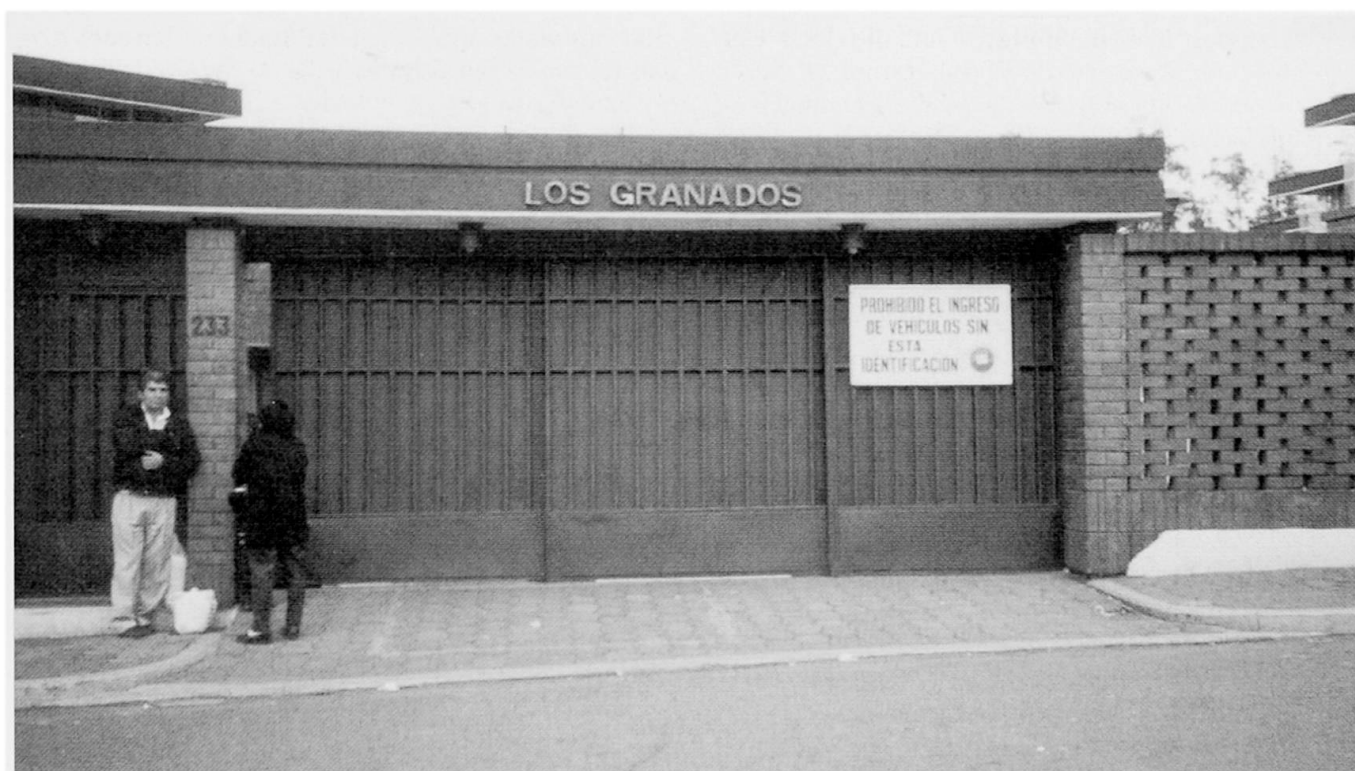
Foto 1: Haupteingang zum Mittelschicht- conjunto Los Granados in Quito Main entrance to the middle class « conjunto » Los Granados in Quito L'entrée principale du « conjunto » Los Granados, pour classes moyennes, à Quito
