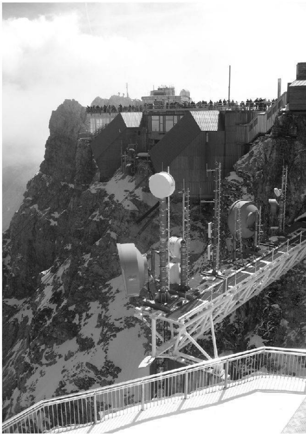
Abb. 1: Bauten auf dem Felsgrat des Zugspitzgipfels Infrastructure on the rock crest of the Zugspitze summit
