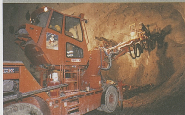
Am Schachtfuss in Sedrun wird seit dem Sommer 2003 wieder gebohrt.
