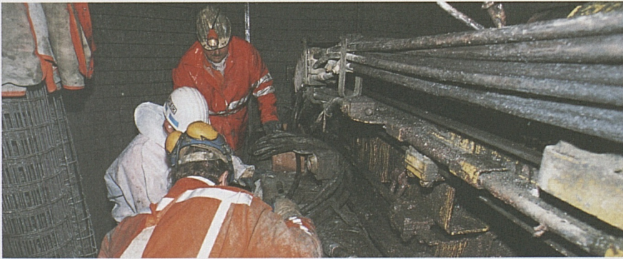
Mineure beim Ankerversetzen im Schacht II.
