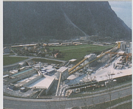
Installationsplatz Grund in Amsteg.
